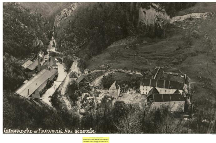
Fig : destruction de la distillerie des Chartreux par un glissement de terrain en 1935. Vue vers l'amont (photographie Collection Lionel Ferrière)
