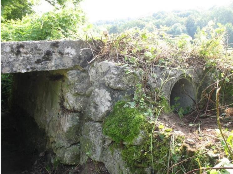
*Ancien pont de pierres, rénové, propre et agrémenté d'une adjonction de buse de diamètre 0,28. Le socle et les montants latéraux sont en pierre, le tablier en dalle de béton armé.*
