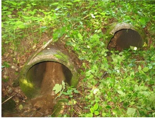
Il s'agit d'un busage ancien sous un chemin communal doublé récemment par une buse. L'écoulement de l'eau s'effectue par un double tube de 57 cm de diamètre chacun.
