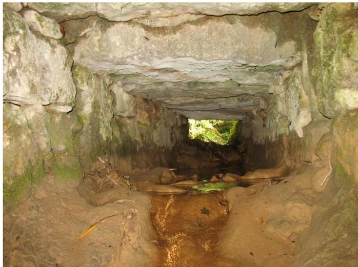
Le « pont du captage », très calcairisé, mérite un nettoyage car son débit est réduit de moitié par des dépôts figés enrobés de calcaire)
