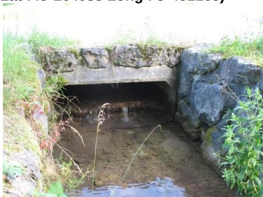
Pont-buse rectangulaire préfabriqué, rénové dernièrement, il est obturé presque pour moitié du fait d'une faible pente, favorisant la calcification des dépôts intérieurs. Un creusement du ruisseau en aval semble nécessaire pour lui permettre d'absorber correctement les crues.
