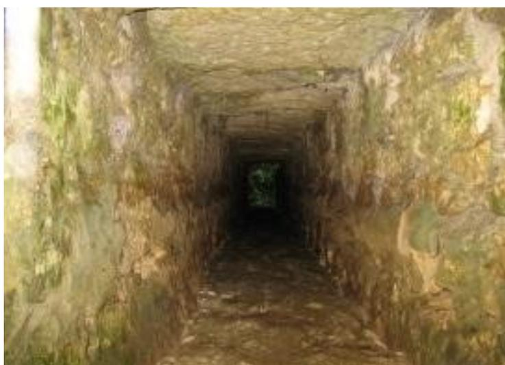
Situé sous le CD 921, au-dessus de la Lanfreyère, ce pont est construit en pierres parfaitement assemblées. Il est très difficile d'accéder à la sortie aval compte-tenu du précipice.
