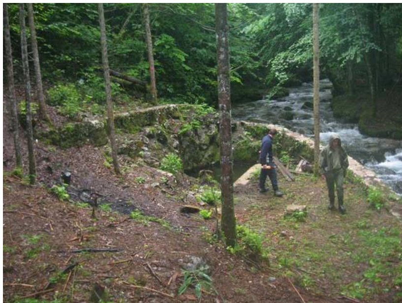
Fig : Le captage de la source Germaine (vue vers l'amont du Guiers) situé en rive droite contre le torrent.
