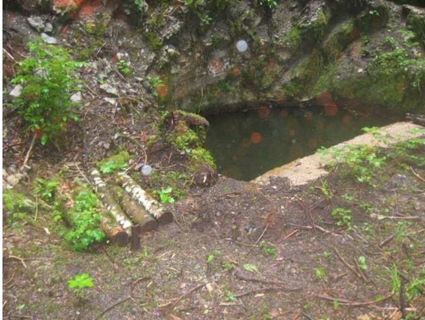
Fig : Les bancs de calcaire et les petits lits de marnes du Berriasien au griffon. Le puisard proprement dit est sous les petits rondins. Le plan d'eau correspond à la descenderie. L'altitude de plan d'eau est celle du griffon et donc de la nappe d'eau souterraine soumise à un faible drainage gravitaire (par un déversement vers le Guiers non vu) Photo Communauté de Communes d'Entremonts
