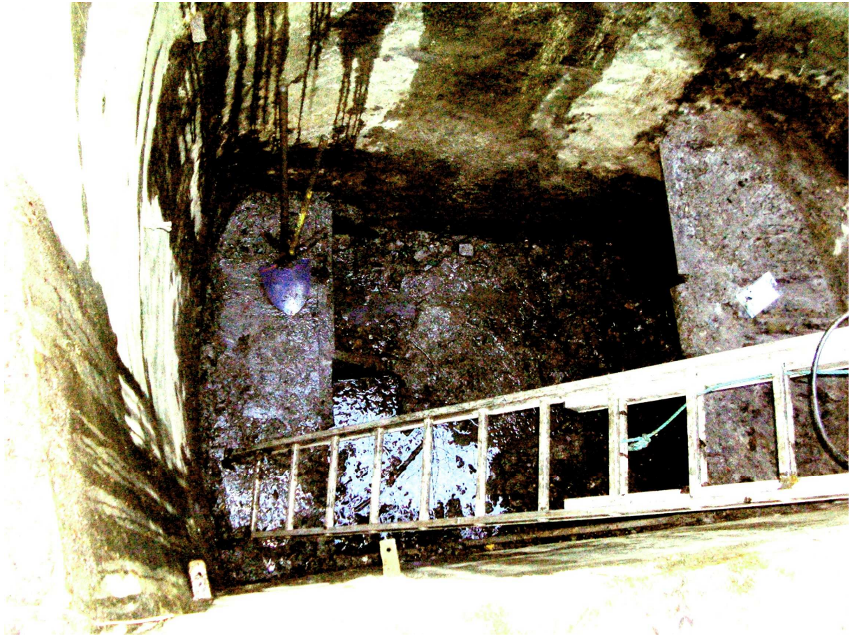
Fig : le fond de la descenderie une fois l'eau pompée. Les murs sont recouverts d'une couche de mortier lissé.
