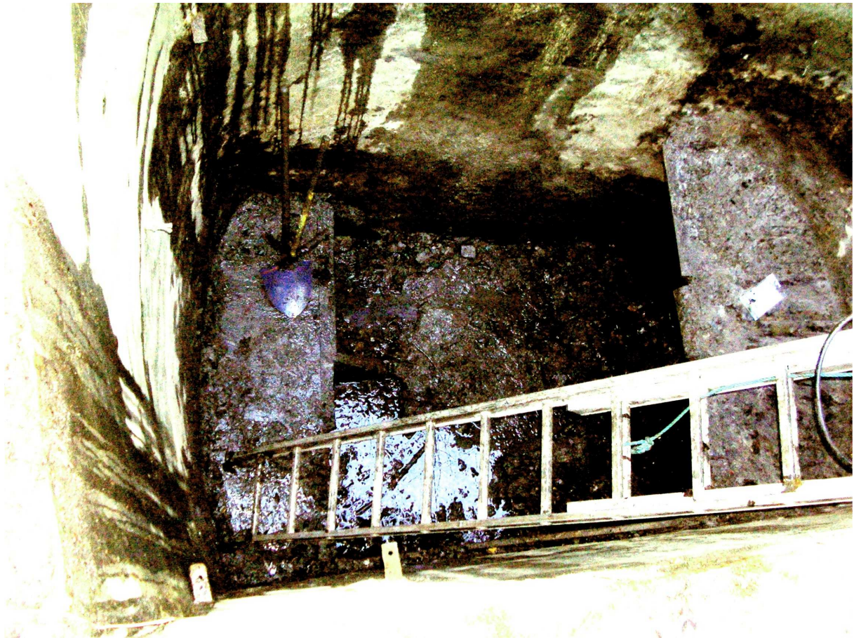
Fig : le fond de la descenderie une fois l'eau pompée. Les murs taillés dans le rocher sont recouverts d'une couche de mortier lissé.
