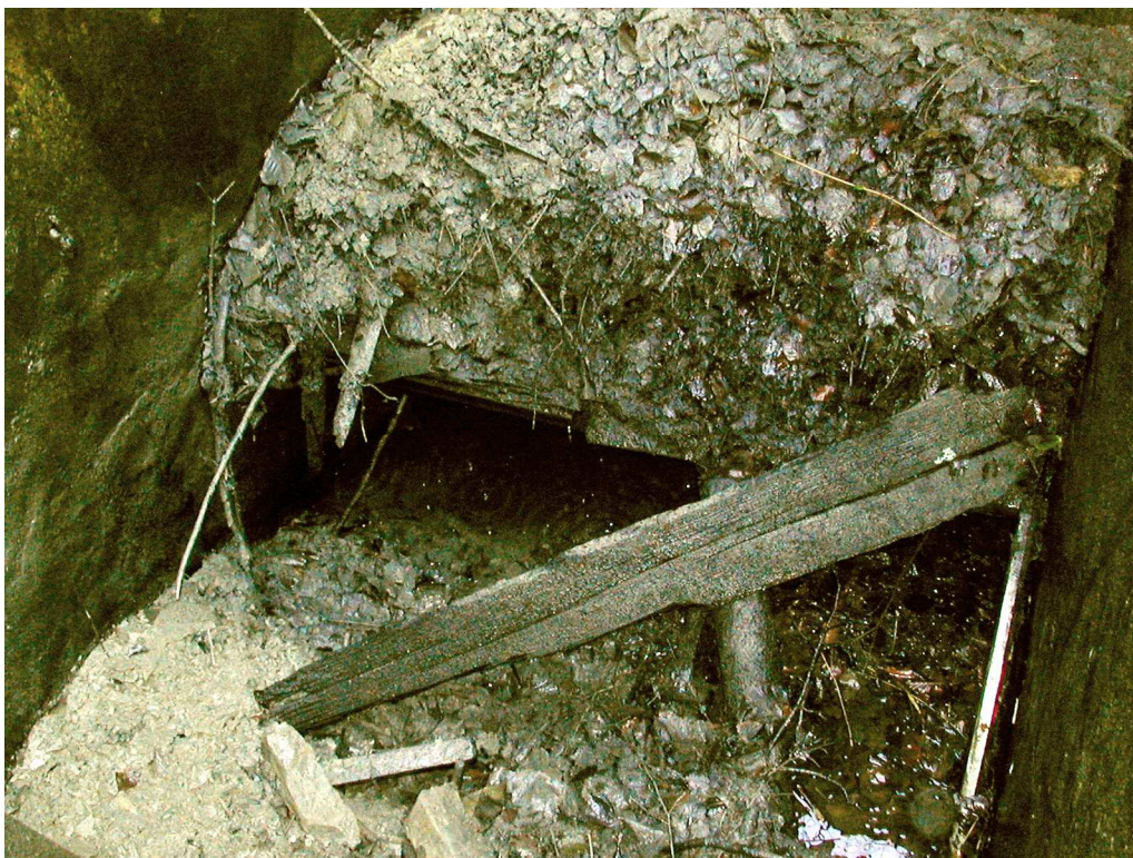
Fig : les restes de l'escalier et des plateformes (encore couvertes de feuilles, branches, vases etc) dans la descenderie
