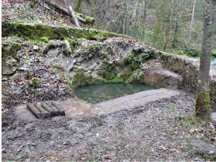
Fig : le site de la source dégagé lors des travaux de janvier 2011. Le Guiers vif à l'extrême droite, la descenderie avec le plan d'eau bordé par les roches du Berriasien et à gauche le trapon du puisard de la source sulfureuse Germaine (avec les 5 rondins).
